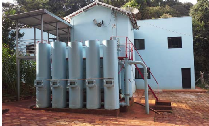
Figura 1: Vista geral da ETA/UFLA.
